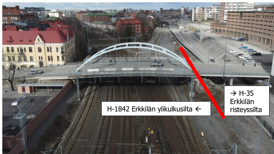
Kuva 2. Valokuva nykyisistä Erkkilän ylikulkusillasta ja Erkkilän risteyssillasta.
